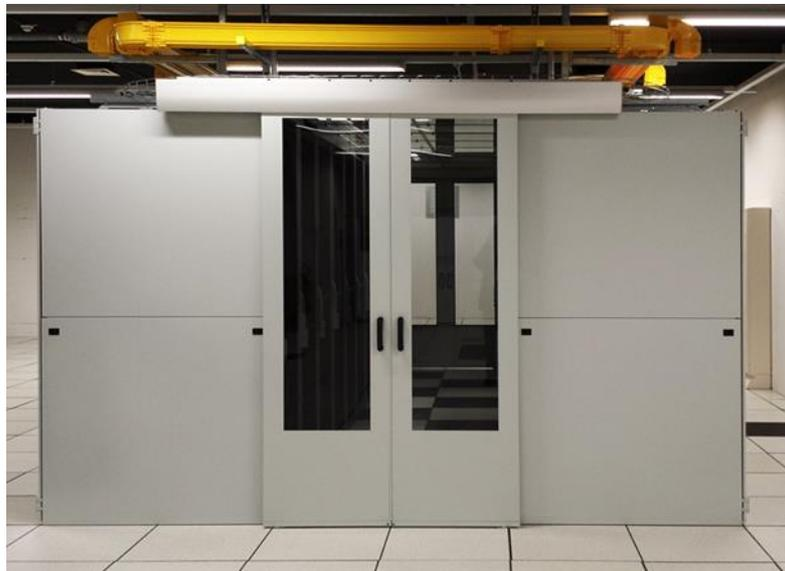
**Figure 8 - Vue d'un couloir « froid » hermétiquement clos dans un système « cold corridor »**
