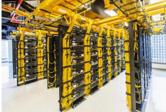
Figure 9 - Photo d'une Meet Me Room câblée en fibre optique
